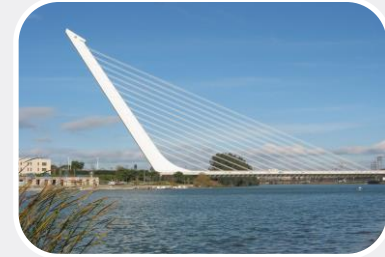
Calatrava.puente del Alamillo
