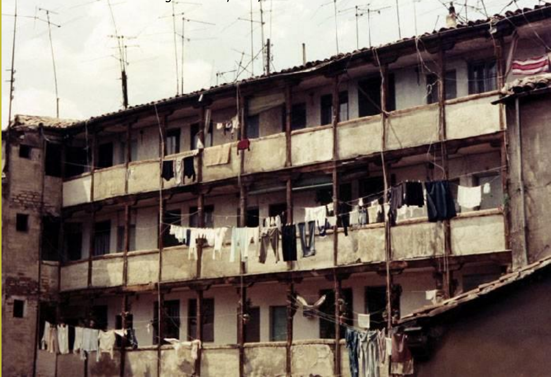
Corrala de Miguel Servet. -finales del siglo XVIII, foto tomada en el año 1976. Calle Miguel servet, 21 c/v Calle del Mesón de Paredes.
